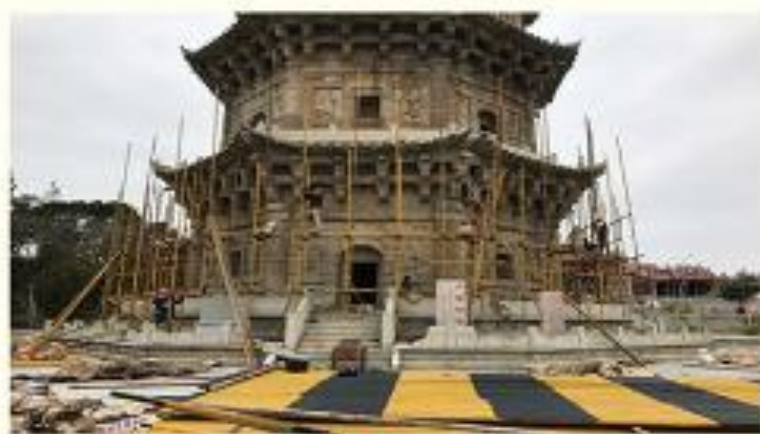
修缮中的六胜塔
